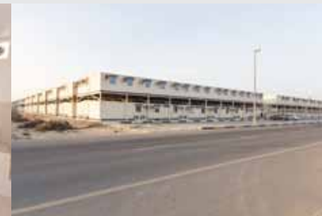
مبنى مكاتب مؤلف من طابقين مدعوم بهيكل صلب إنشائي خارجي A Double Storey Office Building with External Steel Structure Support
