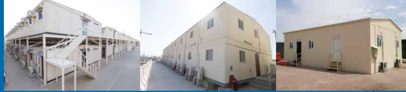
مكاتب بالمنطقة الحرة بالخميرة ارتفاعات مكونة من طابقين، مركبة على الوحدات المكتبية القائمة Hamriyah Free Zone Offices: Double Storey Extensions above existing LOBs
