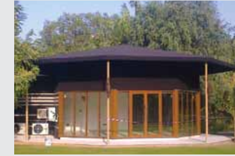
مبنى مجلس مع سقف خيمة A Majlis Building with Tent Roof
