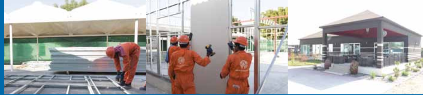
اطار فولاذي خفيف للجدران أثناء التنفيذ داخل ورشة العمل LGS Wall Framing in progress at the workshop
