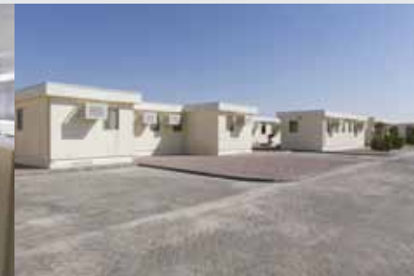
مياني سكن للموظفين في الرويس، لشركة هلالكو، أبوظبي Staff Accommodation Buildings in Ruwais for Hilalco, Abu Dhabi
