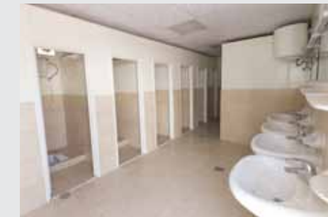
عرض داخلي لمنطقة اغتسال ووضوء An interior view of an Ablution Block
