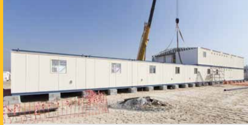
مبنى مكاتب مؤلف من طابقين أثناء القيام بتركيبه A Double Storey Office Building Installation in Progress
